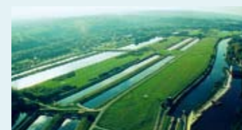
Versickerungsbecken an der Ruhr.
